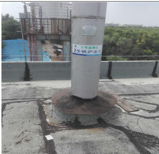
2 号锅炉排气筒出口
