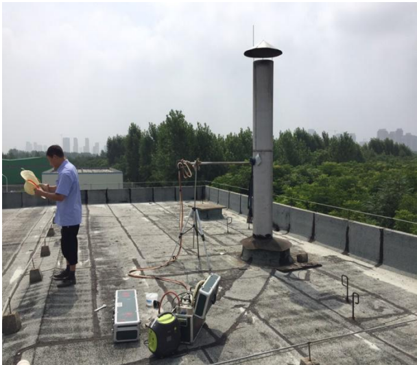
1#锅炉废气排气筒监测点位（◎6）
