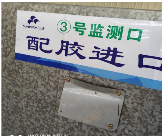
配胶工艺废气排气筒监测进口
