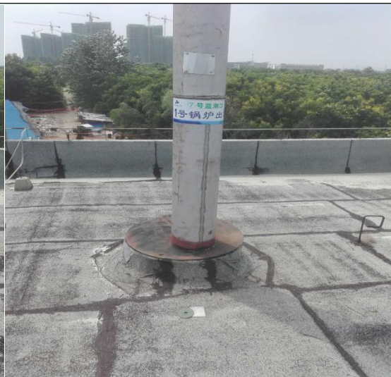
1 号锅炉排气筒出口
